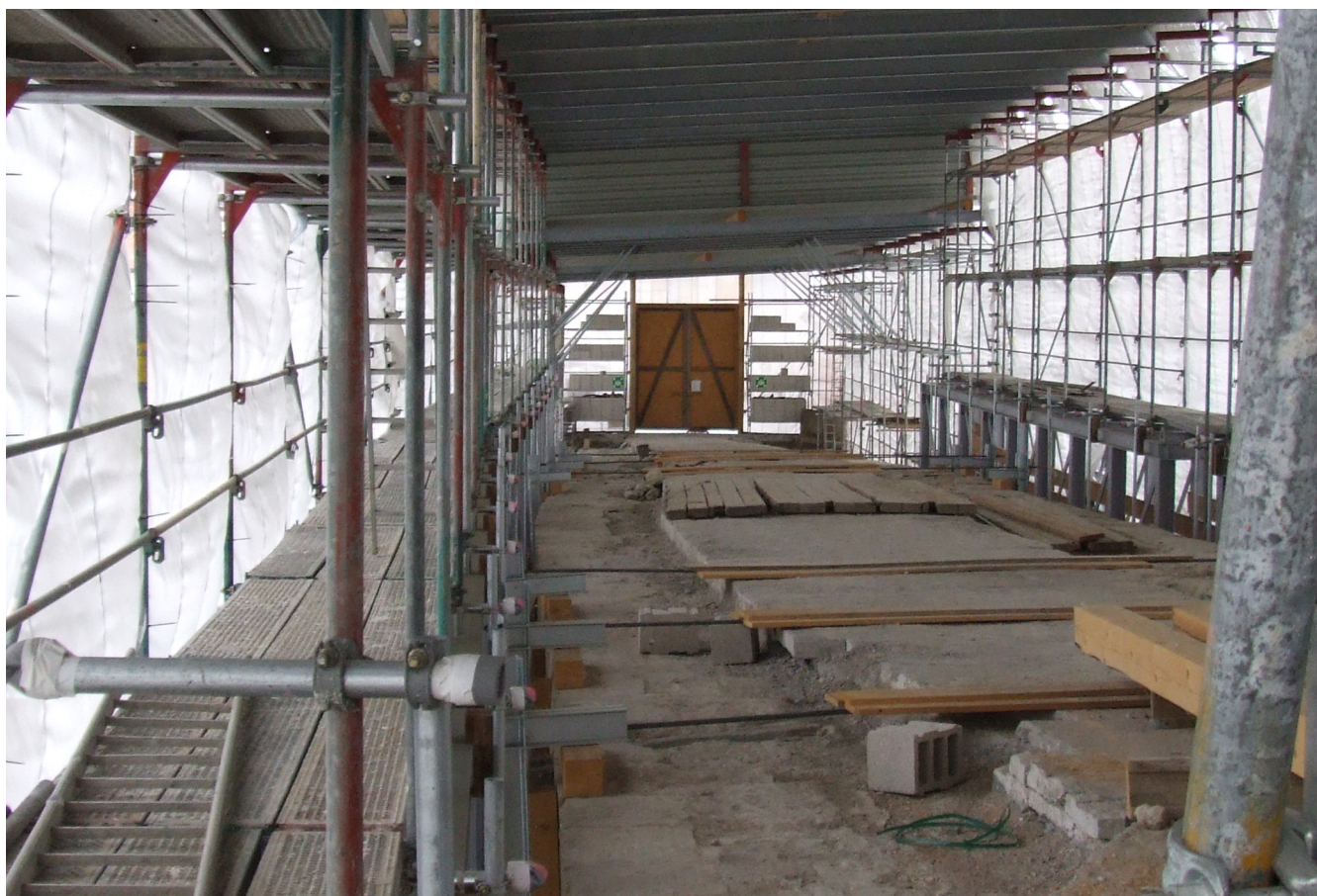
War in der Boomtown Regensburg lange die ruhigste Baustelle: Blick hinter die Planen bei der Steinernen.
