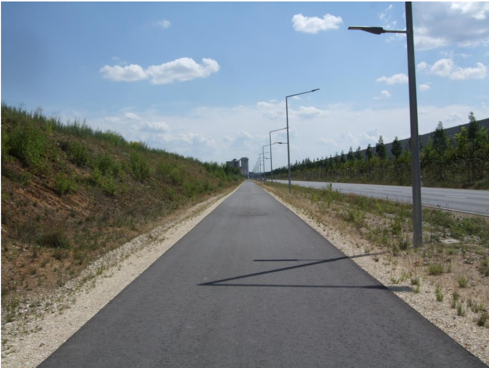
Wirtschaftsweg, Geh- und Radweg entlang der Pilsen- Allee, Blick Richtung Süden, BILD 13, Foto 2014; Quelle: FLU Planungsteam Regensburg
