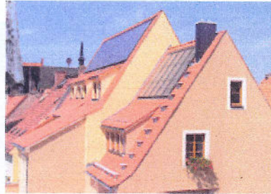
Direkt in die Dachhaut des Schräg- dachs integrierte Solarkollektoren
