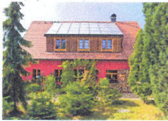
Im Denkmalschutz: Altbausolarisierung in Coswig mit in die Dachgaube integrierten Solarkollektoren
